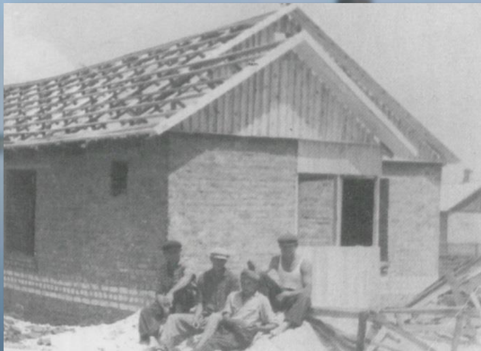
На строительстве дома
