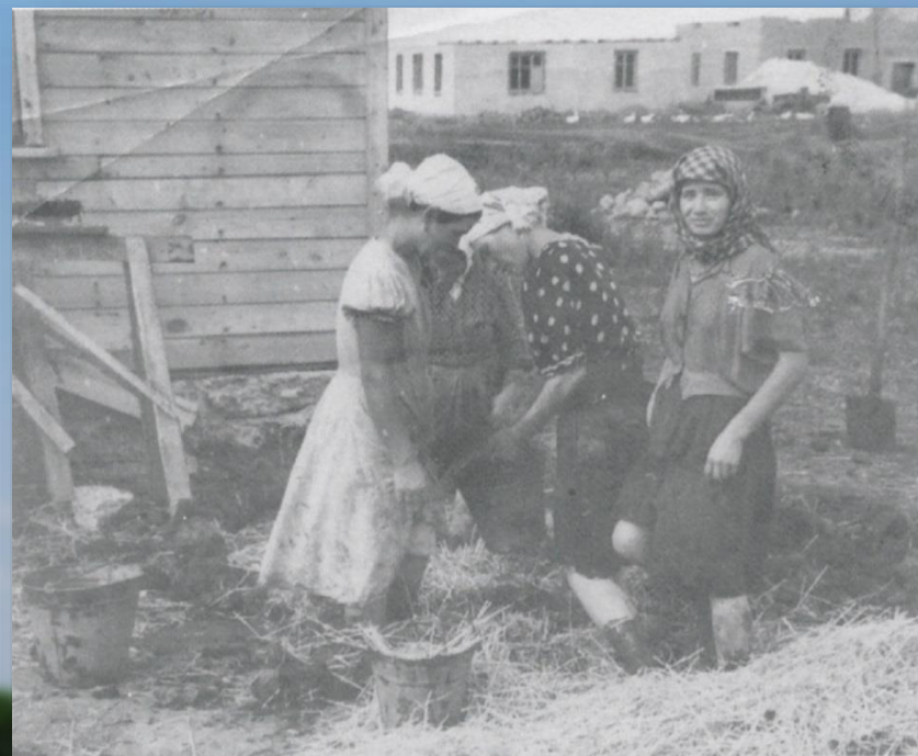
Строительство первых домов
